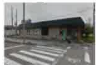
石川県金沢市米里町
